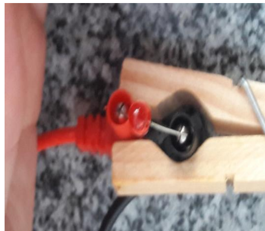
Figura 4 - Ponto de energia
